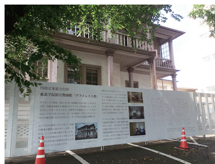
仮囲を設置したデフォレスト館
