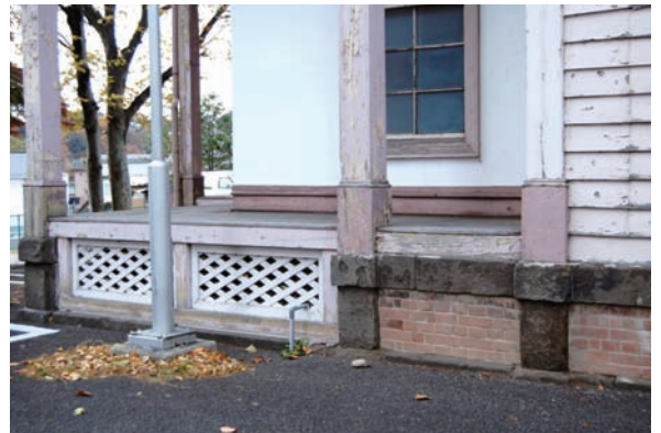
建物東面の土台
