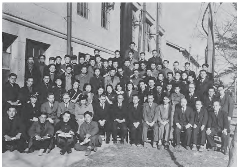
本館南側（1949年3月撮影）
