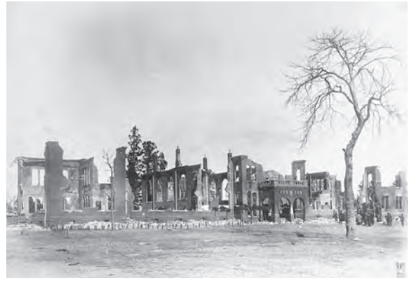
写真13 焼失した普通科校舎
