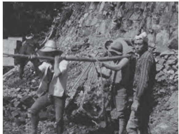
写真24 手作業で行われる道路工事
