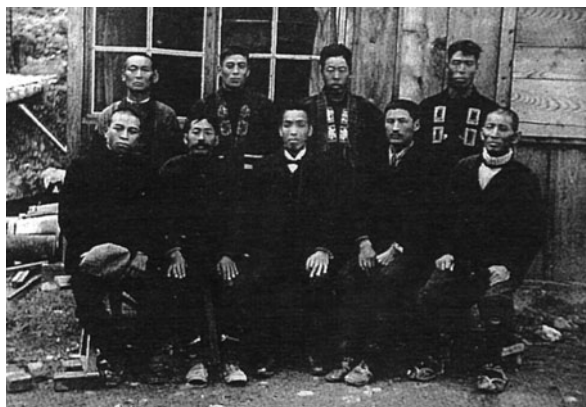
三居沢発電所の石垣工事仲間(前列中央が工事責任者:太田千之助、後列左から2人目:小梨政之助)
