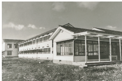
裏側より見た多賀城寄宿舎
